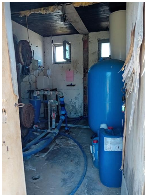
Бунарот и Куќичката со опрема за хлорирање
