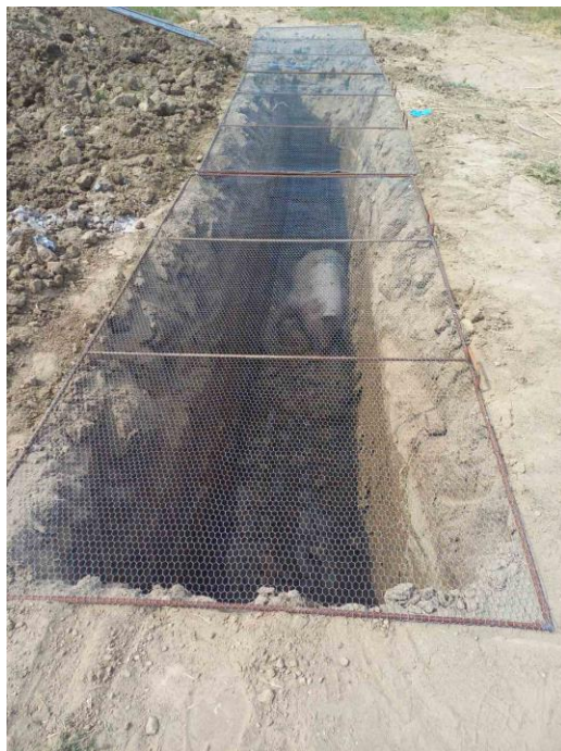
Јама за закопување покриена со заштита решетка
