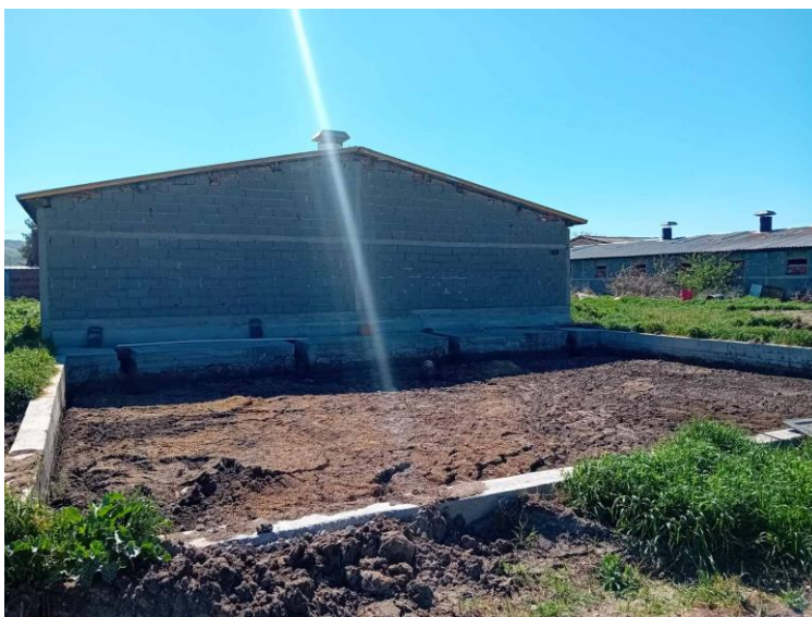
Собирна бетонска јама – лагуна
